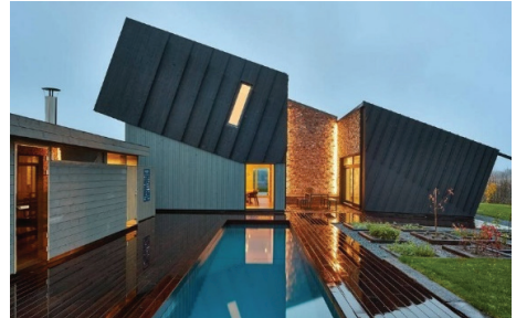
Мал. 122-19. Энергаэфектыўны дом у Нарвегіі
