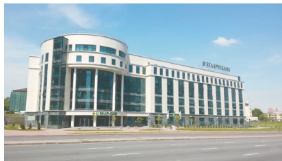
Рис. 211. Центральный офис ОАО «Беларусбанк» в г. Минске
