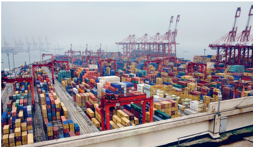
Рис. 198. Контейнерный порт Шэньчжэнь (Китай)
