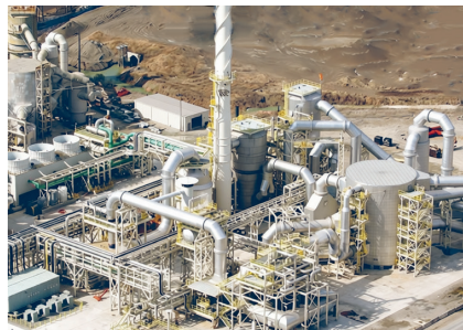
Рис. 177. Завод по производству азотных удобрений в Китае
