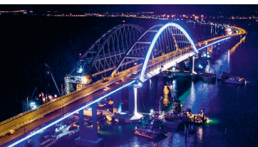
Символом масштабного строительства стал Крымский мост. Его протяженность — 19 км. 2018 г.
