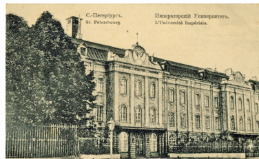
Імператарскі ўніверсітэт. Г. Санкт-Пецярбург
