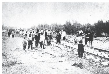
Строительство железной дороги. Вторая половина XIX в.
