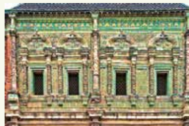
Фасад второго этажа Крутицкого теремка. Москва. 1681–1694 гг.
